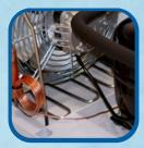
Système d'évaporation automatique des condensats par serpentin chauffant en acier inox
